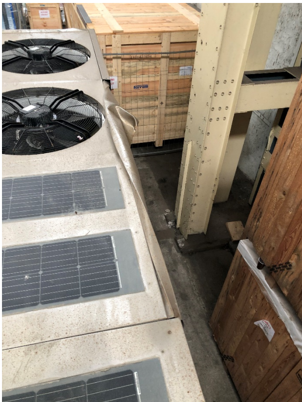
Ansicht: Schaden Ansaugung oben links
